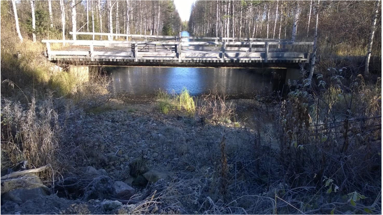
Kuva 8. Näkymä Panumanojan oikaisukanavan yläosasta (noin paalu 118).
